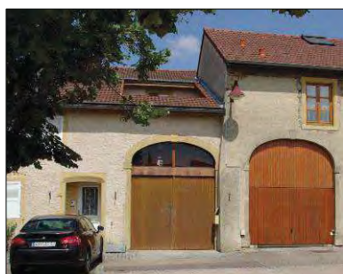
L'ouverture dans le toit
