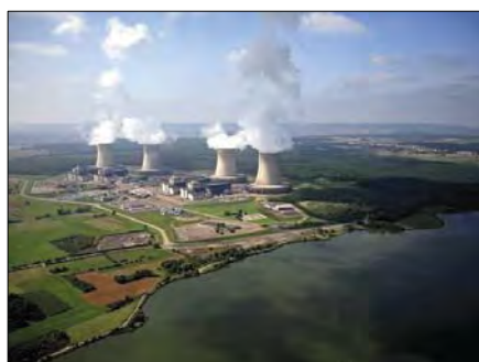
La centrale Nucléaire de Cattenom
