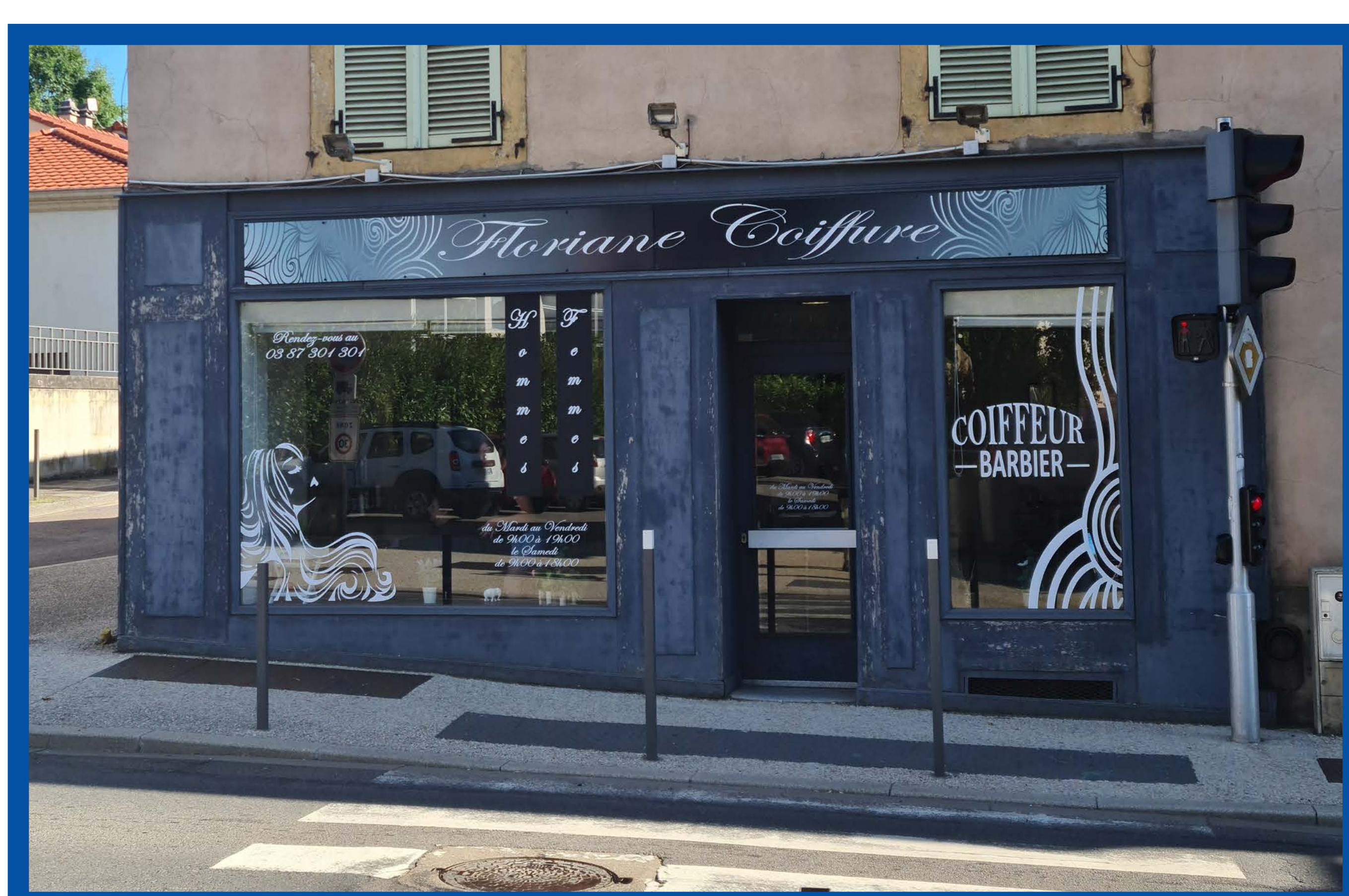
Enseigne parallèle à la façade
