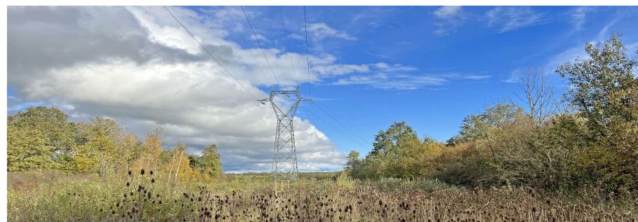
Implantation sous les lignes RTE, où un broyage de la végétation est assuré de manière régulière.
