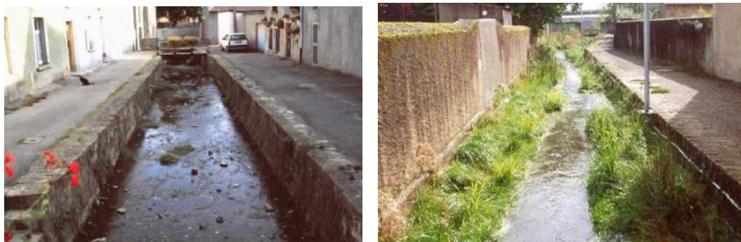
Figure 9 : Travaux d'aménagement réalisés sur le ruisseau du Montvaux. Exemple d'un site, avant et après la création de berges végétales. (Source : Agence de l'eau Rhin-Meuse).
